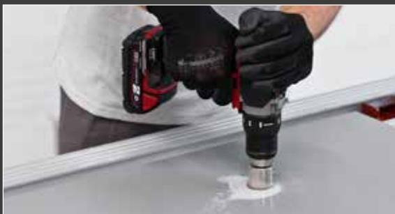
La nostra linea di macchine e foretti diamantati offre soluzioni per forare, prima e dopo la posa, piastrelle e lastre in porcellanato (anche di soli 3 mm di spessore), mono e bicottura, marmo, granito, pietre naturali, ecc... fino a 120 mm di diametro, partendo da 4 mm. Dalla macchina carotatrice super professionale ideale per una comoda e semplice esecuzione dei fori, fino a soluzioni più semplici ma non certo meno efficaci quali i foretti ad umido.
